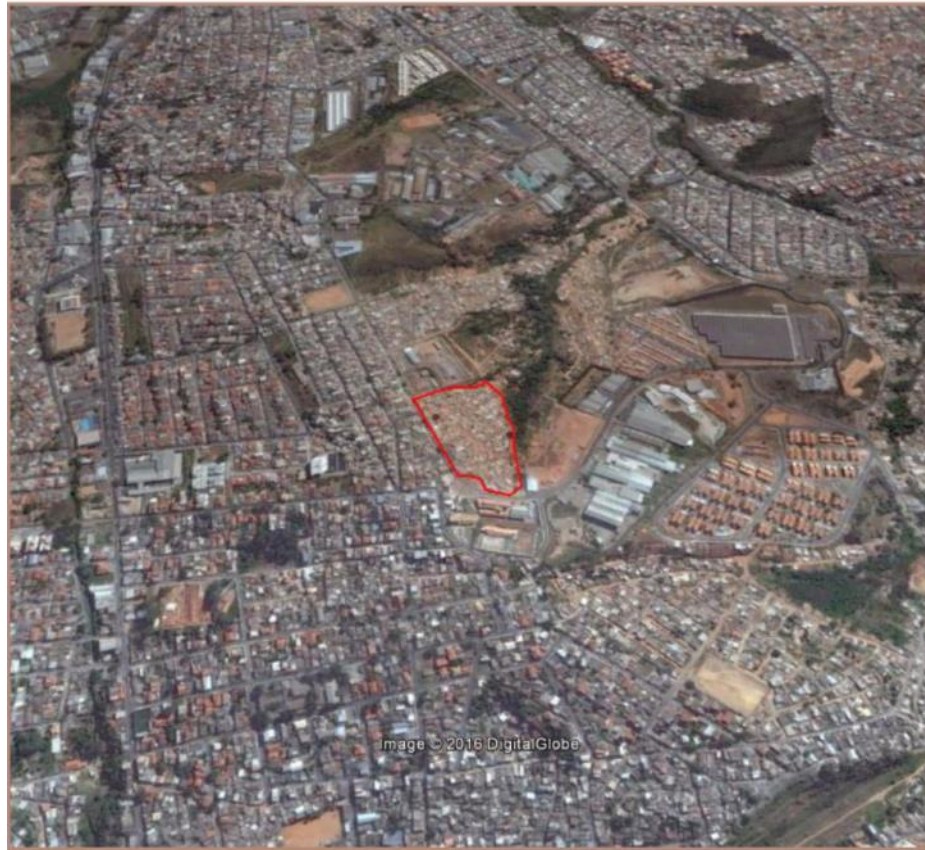
Figura 19: Vista aérea, Vila Santa Rita, Barreiro Fonte: Base Google Earth, data 2015
